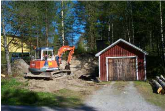
Fig. 4. Grävningplatsen. Garaget står sannolikt exakt på den plats där Haldan Andersson hade påbörjat sin grundgrävning på 1920-talet. Foto: förf.
